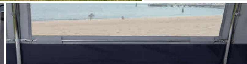
▲ Speciale hoezen in de zijwand voor de plaatsing van de standaard dwarsliggers.
